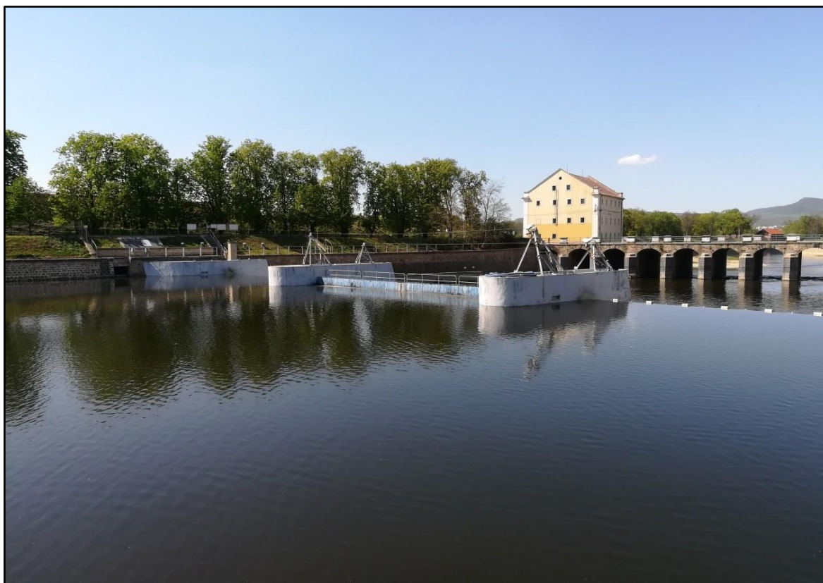
Foto č. 6 – Provizorní hrazení z horní vody po montáži (pohled z nadjezí VD)
