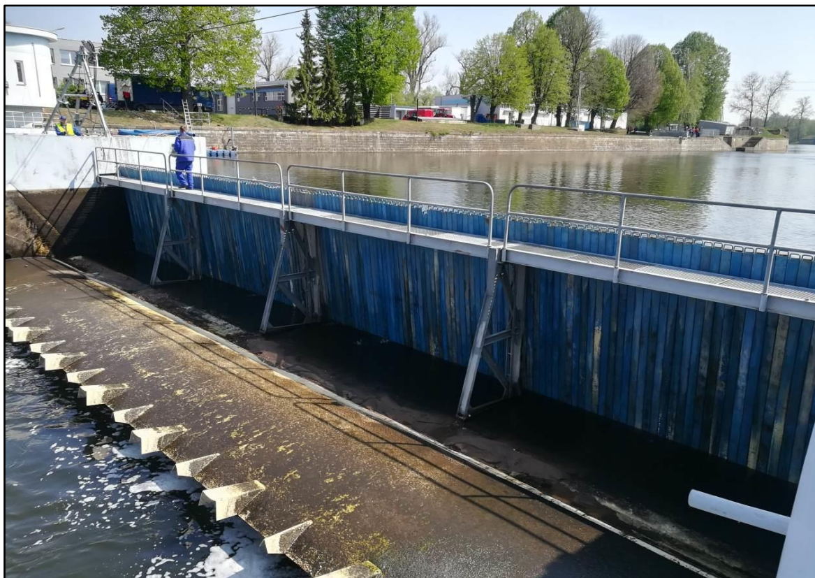
Foto č. 6 – Provizorní hrazení z horní vody po montáži (pohled z nadjezí VD)
