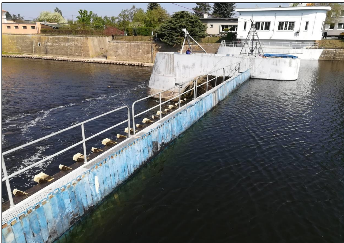
Foto č. 4 – Provizorní hrazení z horní vody po montáži (pohled z pilíře)
